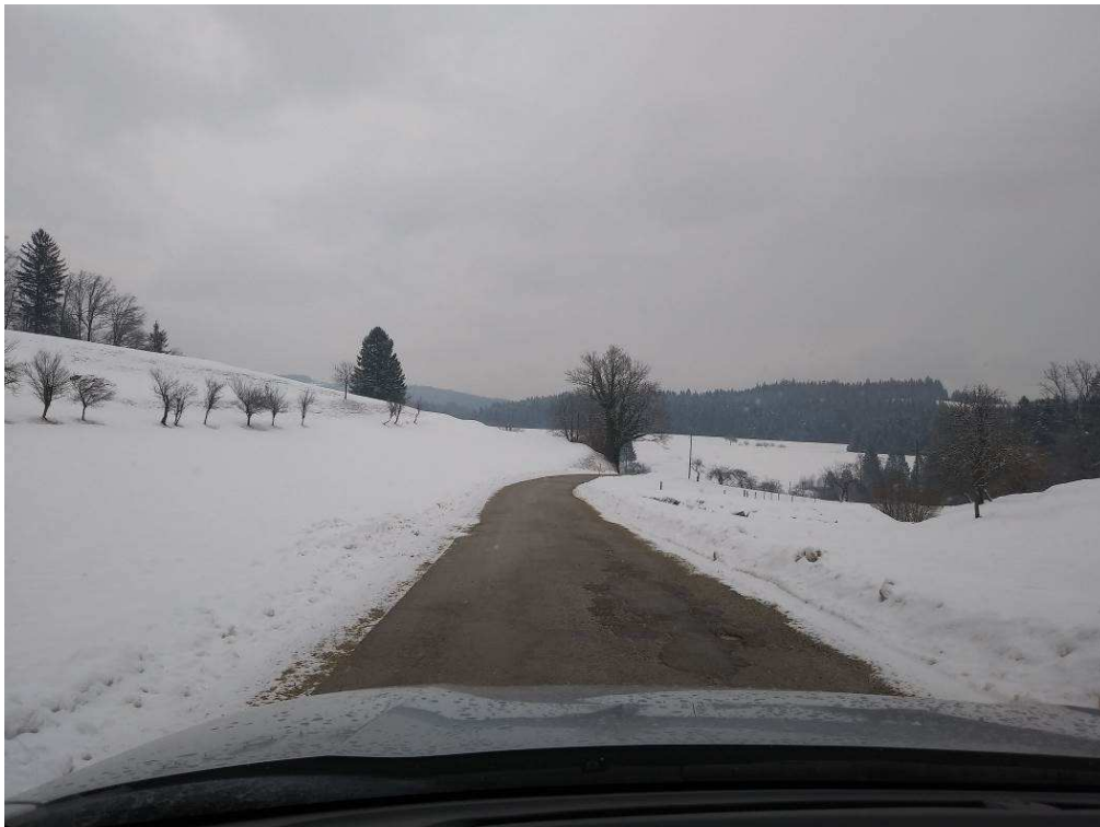
Slika 6: Pogled na traso
