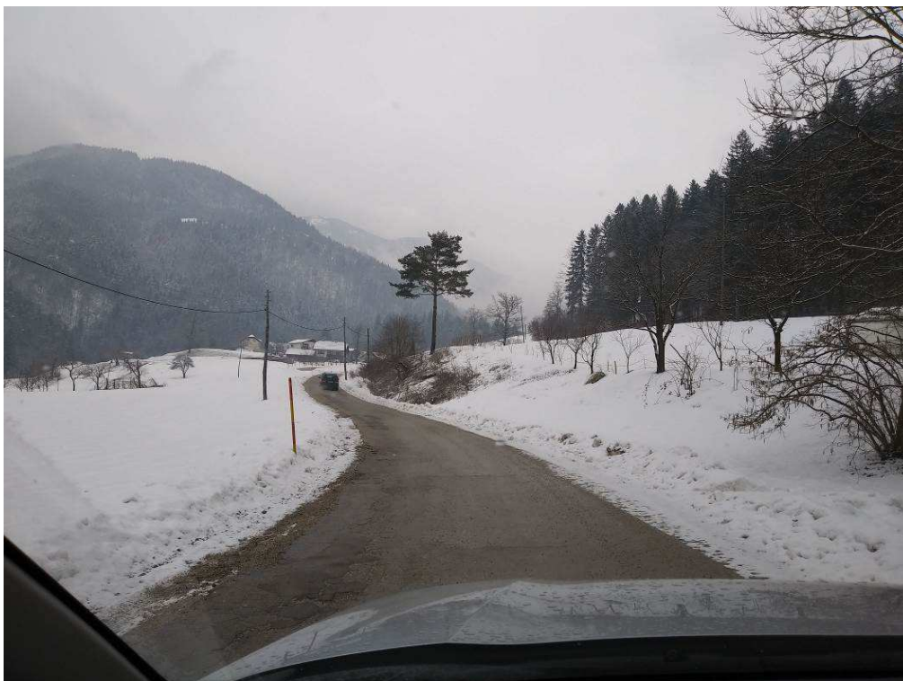
Slika 5: Pogled na traso
